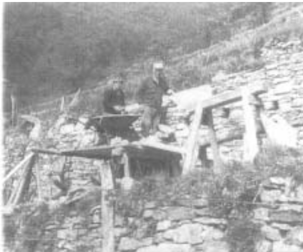
Steinmauerwiederherstellung in mühsamer Handarbeit
